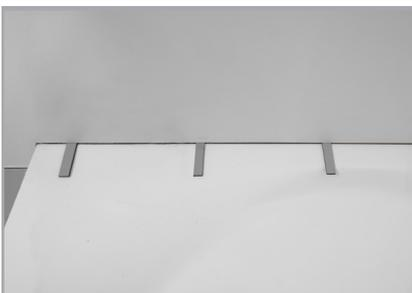
**Bringen Sie die Platte in Position** und kontrollieren Sie den 2-3 mm Abstand zu allen festen Teilen. Danach drücken Sie die Platte gleichmäßig an.
