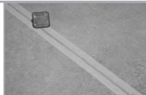
5. Bringen Sie links und rechts von der Fuge ein **Klebeband** an und **füllen die Fuge mit Silikon**. Ziehen Sie das überschüssige Silikon eben ab.
