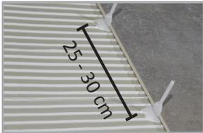
1. **Positionieren** Sie die **Schraublasche** unter die Platte mit einem Abstand von 25 bis 30 cm zwischen den Schraublaschen.
