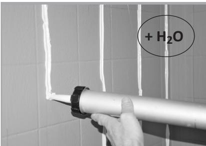
**Die Verklebung kann auch streifenweise mit einem Raupenabstand von maximal 25 cm erfolgen**, zum Plattenende ca. 4 cm Abstand lassen. Im Bereich wo später Gegenstände (Waschbecken, WC, Klappsitz etc.) befestigt werden, darf die Wand dahinter nicht hohl sein. Füllen Sie diesen Bereich mit einem sehr kleinen Raupenabstand.
